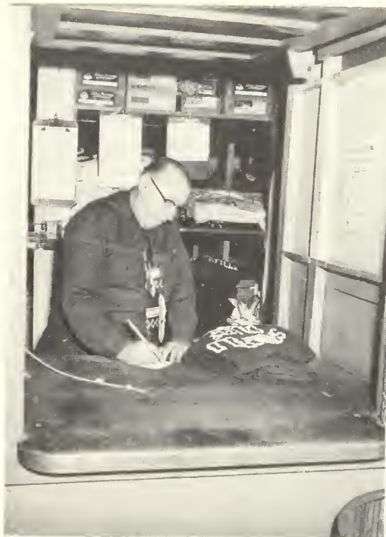
Equipment Room—Carl Ambler
